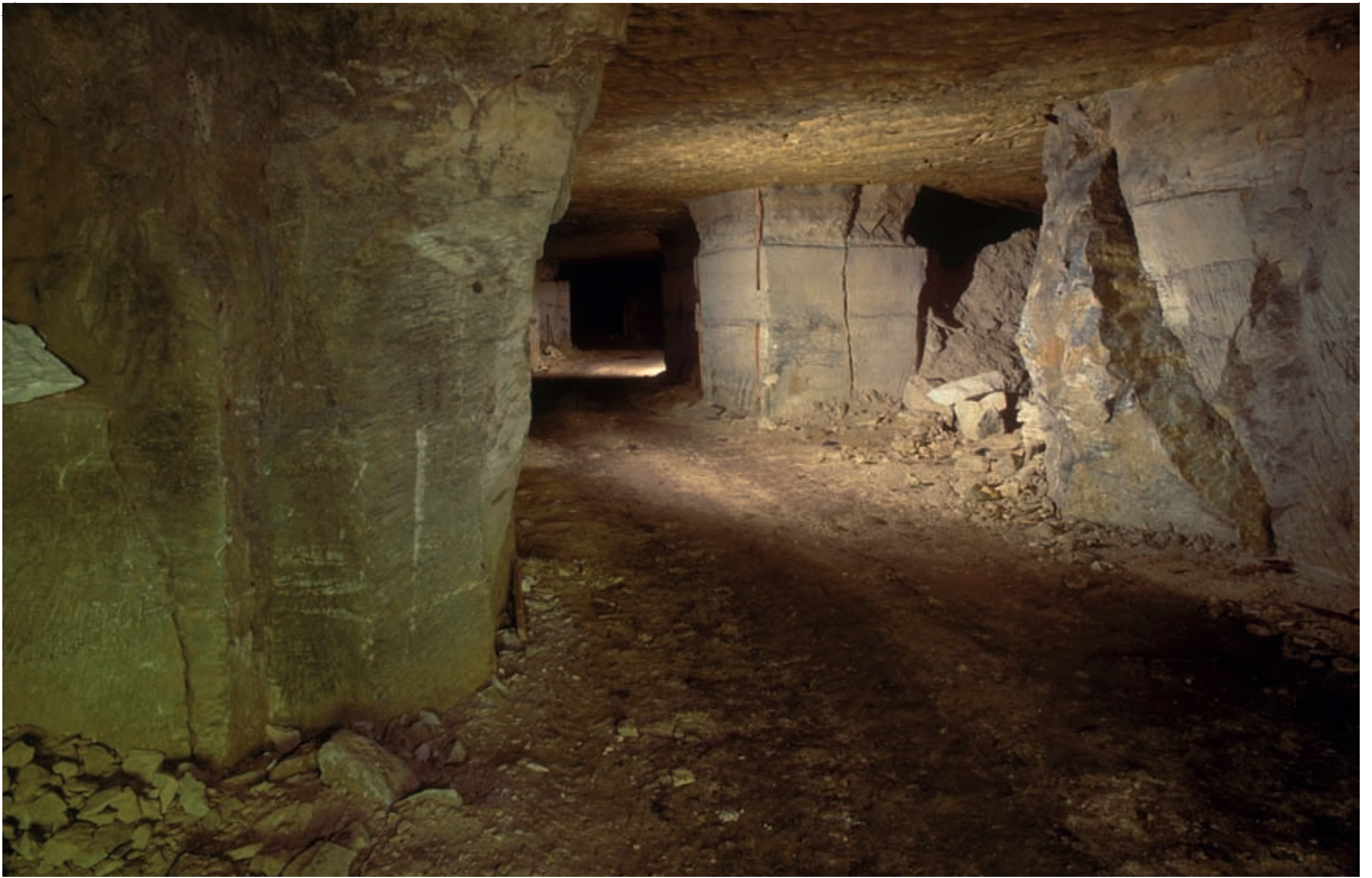
1 Carrière souterraine à l'abandon à Aulnois-en-Perthois © FRANÇOIS SCHWAAB 2 Petit rhinolophe en hibernation dans une carrière souterraine © DAVID AUPEMANN
