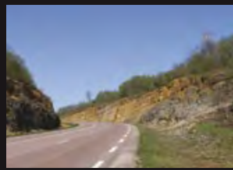
Front de taille de la route à travers la côte de Moselle à Rollainville
